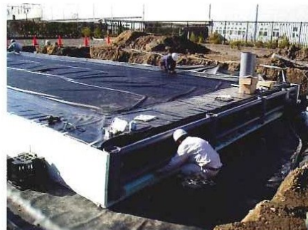
施工中的中规模地下储水槽
