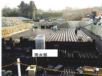
施工中的大规模地下储水槽
