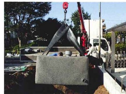
小规模储水槽在工场组装后直接运到施工现场，用吊车起吊。
