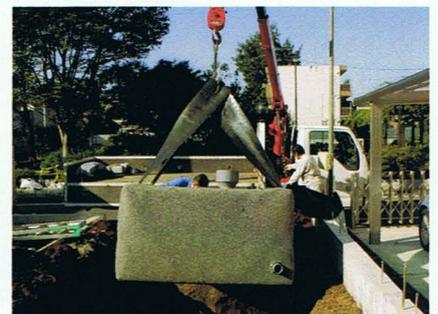
小规模储水槽在工场组装后直接运到施工现场，用吊车起吊。
